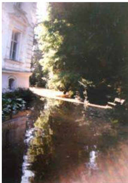
Ryc. nr 52. Budynek przy ul. Parkowej 1/3 (Aut. Zofia Strożecka-Tichy).
