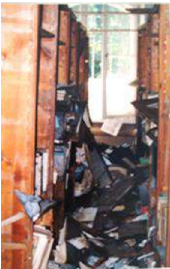
Ryc. nr 5. Magazyny w budynku Biblioteki przy ul. Parkowej 1/3. Stan po powodzi. (Zofia Strożecka-Tichy)
